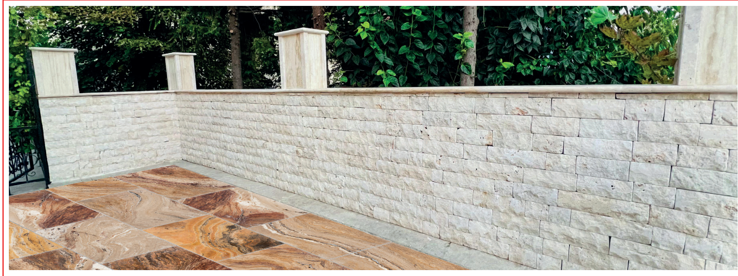
COUVRE MUR AVEC GOUTTE D'EAU
